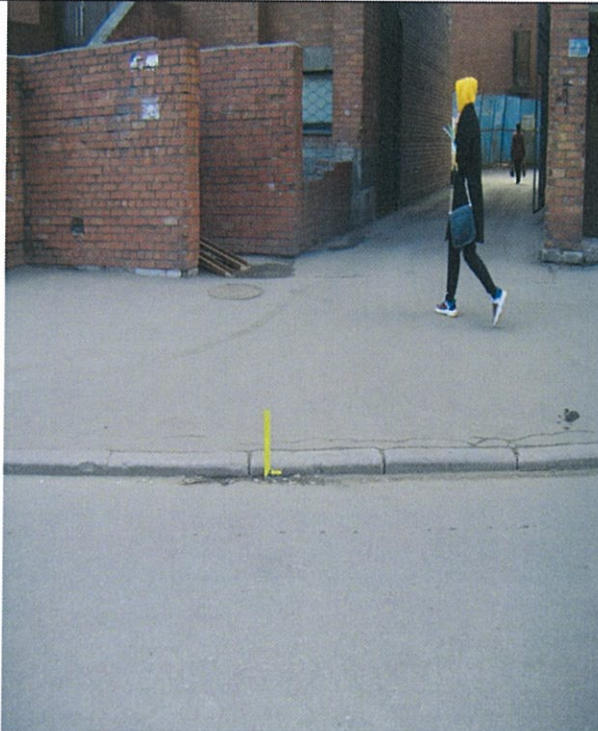
Фото 1. Перепад высот в местах съезда на проезжую часть
