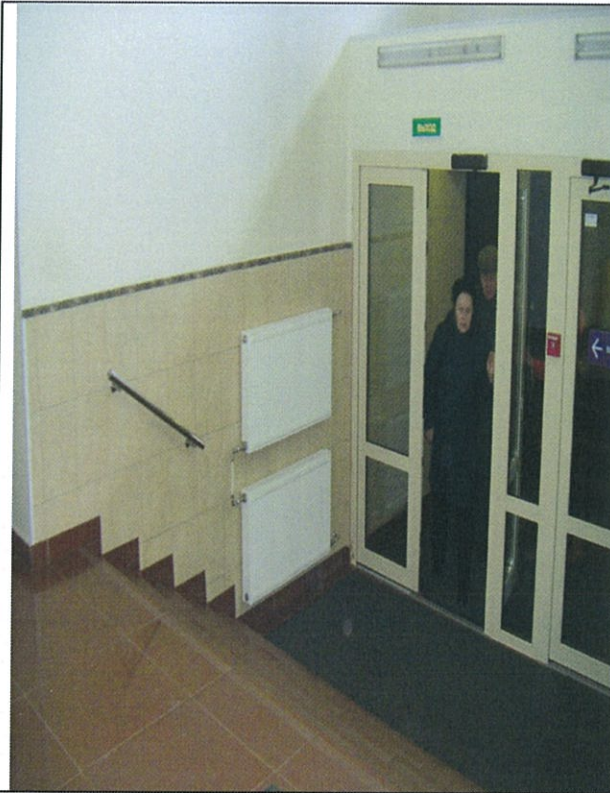
Фото 13. Внутренняя лестница входного узла
