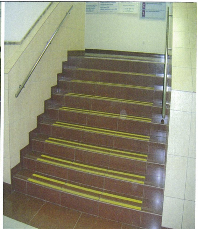
Фото 14. Лестница к лифтам 1 этажа.
